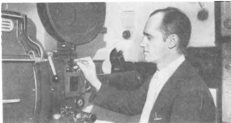
С. Шубин — технорук кинотеатра «Победа» производит профилактический осмотр проектора
