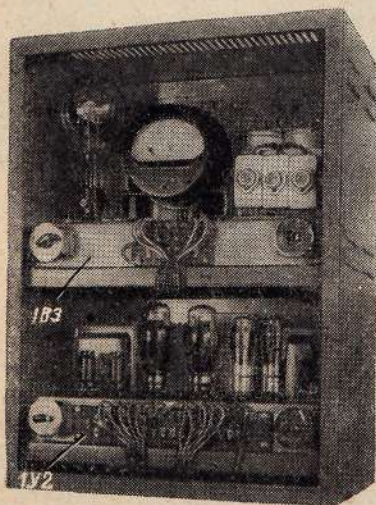
Рис. 14. Шкаф УСУ-8 с открытой крышкой
