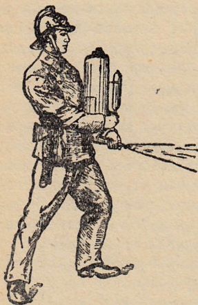
Рис. 9. Приведение в действие огнетушителя «Титан»
