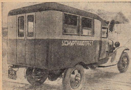
Облегченный кузов звуковой автокинопередвижки конструкции Н. А. Копысова и С. И. Порошина, изготовленный Глазовской киноремонтной мастерской
