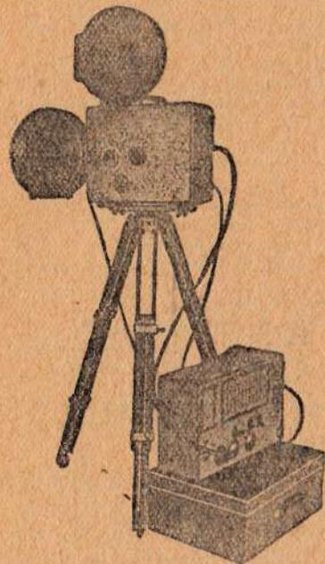
Рис. 61. Передвижка с усилителем УК-25 или УКМ-25, установленная для проведения сеанса.
