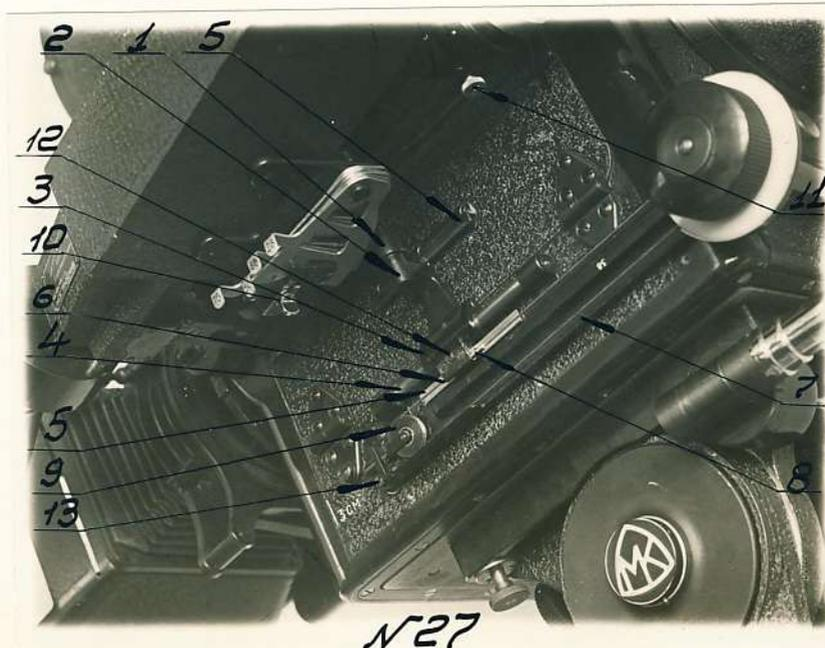
Рычаг /фото № 27,2/ с установленным на нем роликом /7/ шарнирно соединен с ползуном/8/, скользящим по направляющей /4/. Верхний конец рычага и нижний ползуна скользят по направляющим/5/. Шарнир обеспечивает возможность открывания дверцы аппарата.
