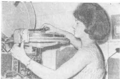
Рис. 4. Укладка рулона в сматыватель
