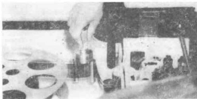
Рис. 5. Измерение натяжения фильма динамометром Д-10
