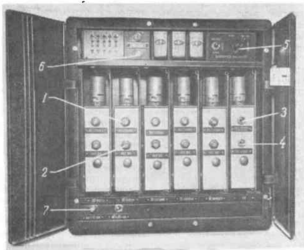
Рис. 5. Шкаф предварительных усилителей комплекта 25-УЗС-1
