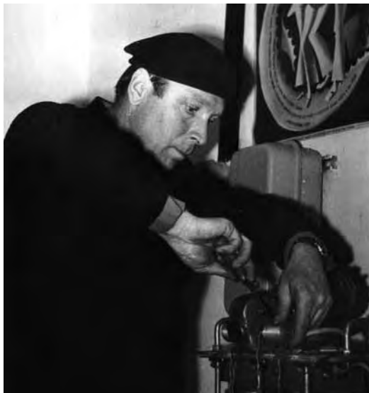
1970 г., санаторий «50 лет Октября», монтируется киноустановка в клубе
