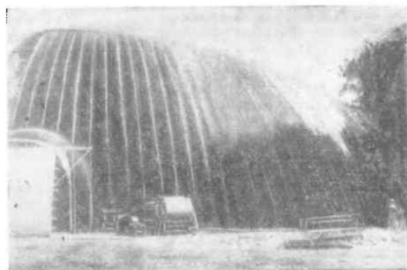
Рис. 7. Рабочие моменты сборки и установки надувной конструкции передвижного панорамного кинотеатра «Синерама — Европа-1»
