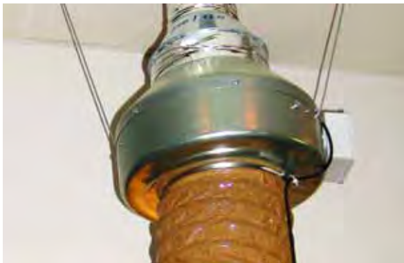
Вентилятор дополни- тельного охлаждения
