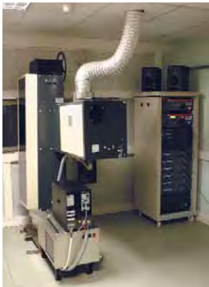
Стойка с процессорами и усилителями
