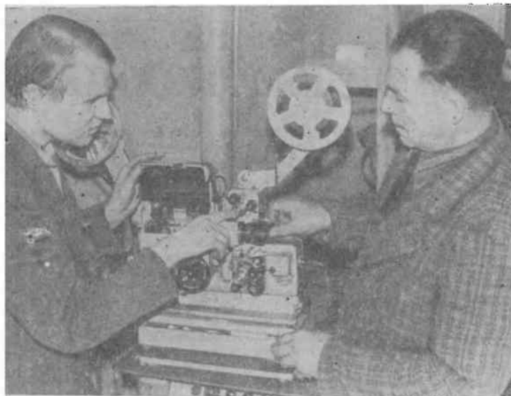
Старший мастер реммастерской В. Лехин (слева) проводит контроль отремонтированной аппаратуры на испытательном стенде
