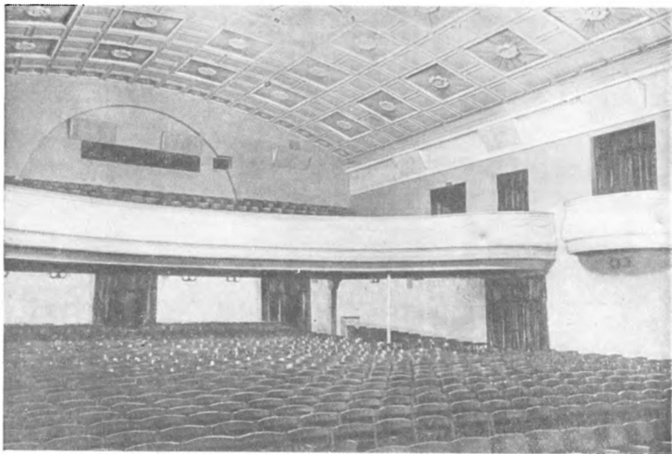
Рис. 1. Общий вид зрительного зала кинотеатра «Художественный». Потолок облицован архитектурно-акустическими блоками
