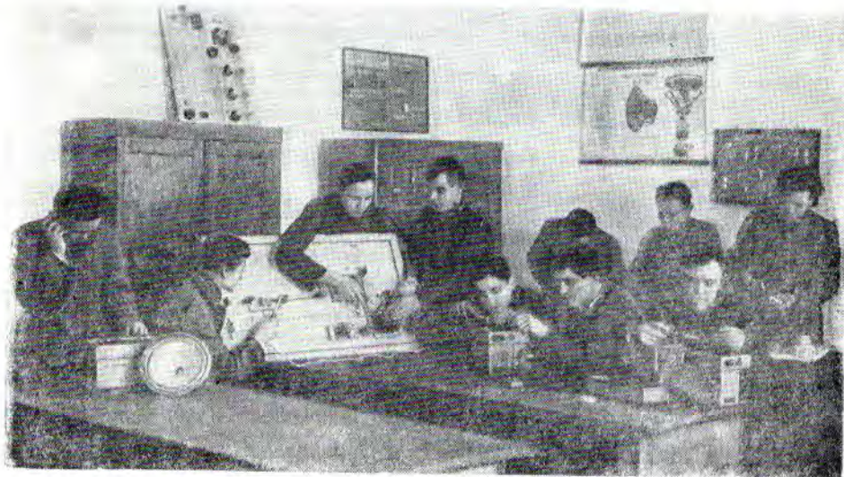
Учащиеся Сороческой школы кинемехаников испытывают изготовленный ими действующий макет усилительного устройства
