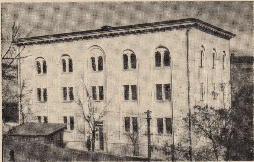
Новая республиканская фильмобаза в г. Тбилиси. Строительство ее закончено в 1952 году. Фильмобаза сооружена по типовому проекту
