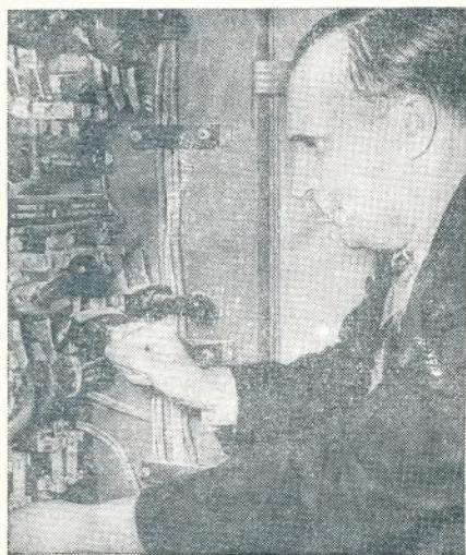
Технорук С. Рыков проверяет распределительное устройство
