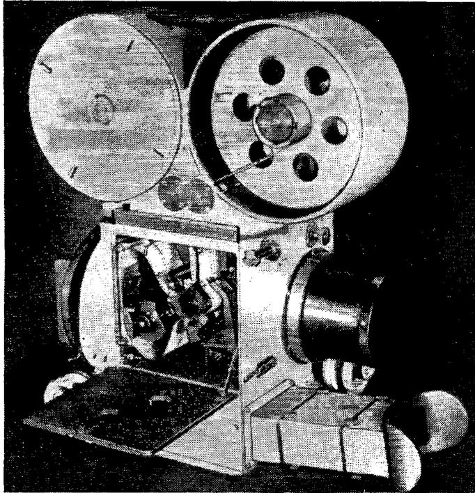
Рис. 117. Путь прохождения пленок и их взаимное расположение в киносъемочном аппарате «Панорама»
