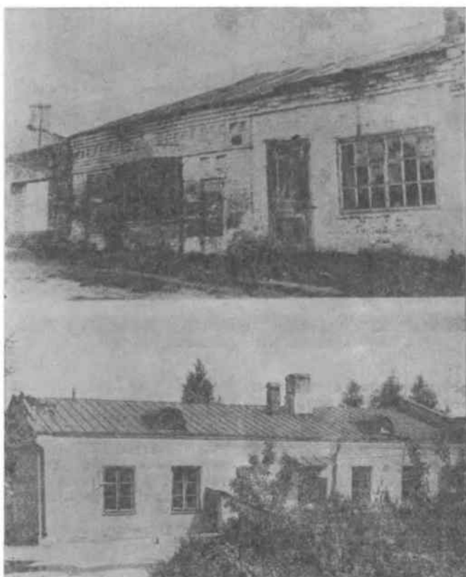
Старое и новое здания Дмитровского отделения кинопроката (Московская обл.)
