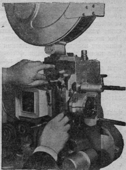
Рис. 130. Закладка фильма в фильмный канал аппарата
